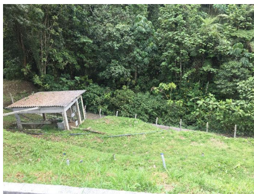
Imagen 8: Cerramiento perimetral con cerca
