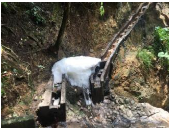
Fuente: Registro Fotográfico SSPD – Visita octubre 2018
