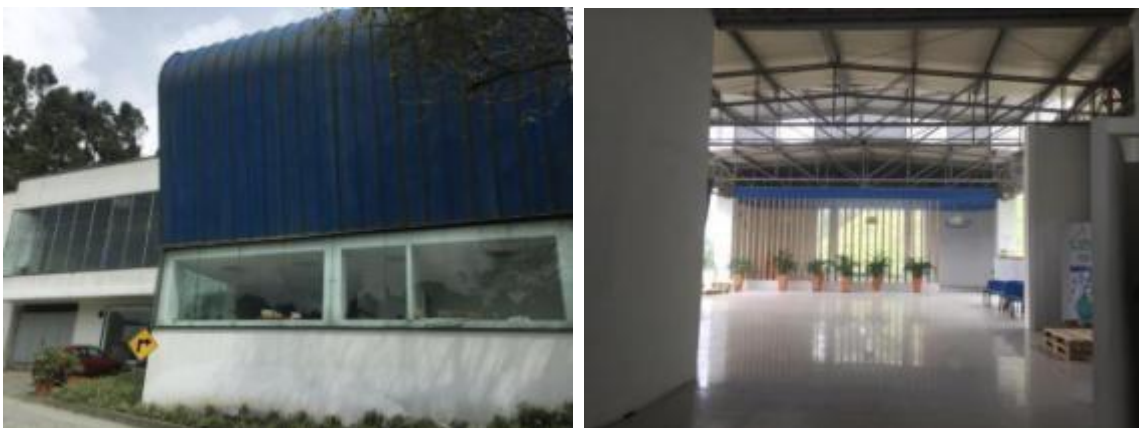
Fuente: Registro Fotográfico SSPD – Visita octubre 2018
