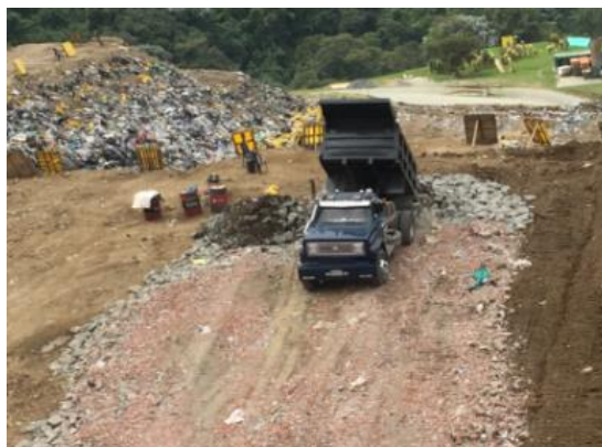
Fuente: Registro Fotográfico SSPD – Visita octubre 2018
