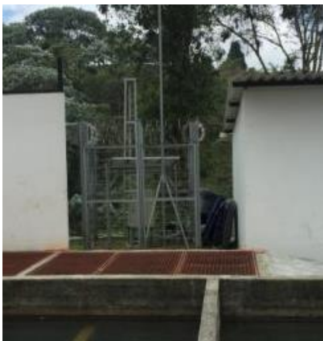
Fuente: Registro Fotográfico SSPD – Visita octubre 2018
