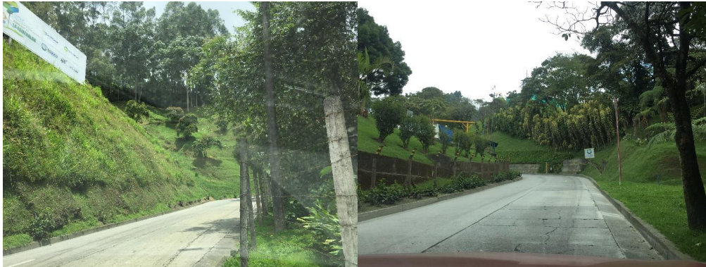
Imagen 6: Vía hacia el relleno sanitario
