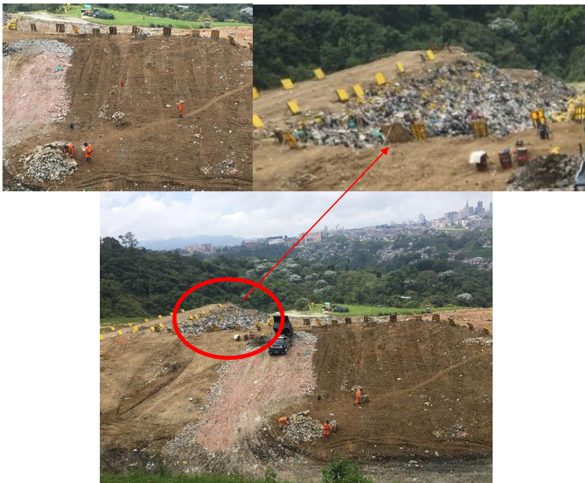
Fuente: Registro Fotográfico SSPD – Visita octubre 2018
