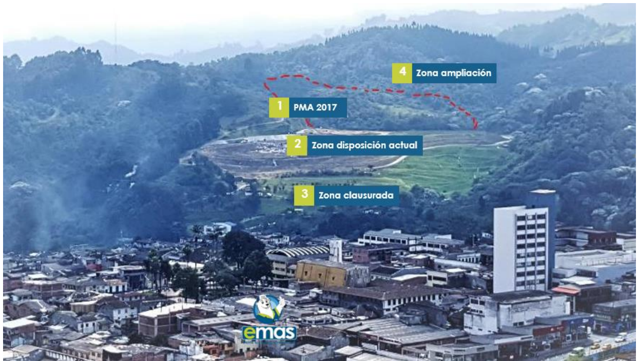
Imagen 3: Vista General del Relleno Sanitario
