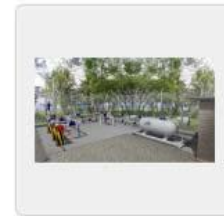
ESTACION DE TRANSFERENCIA BUENOS AIRES
