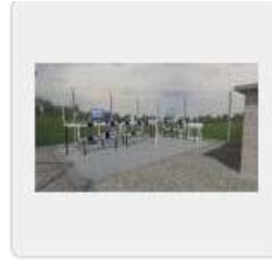
ESTACION CITY GATE ESPINAL
