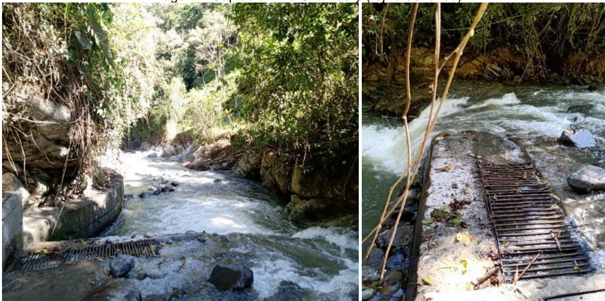
Imagen 7. Captación Río Chambery (rejilla de fondo)
