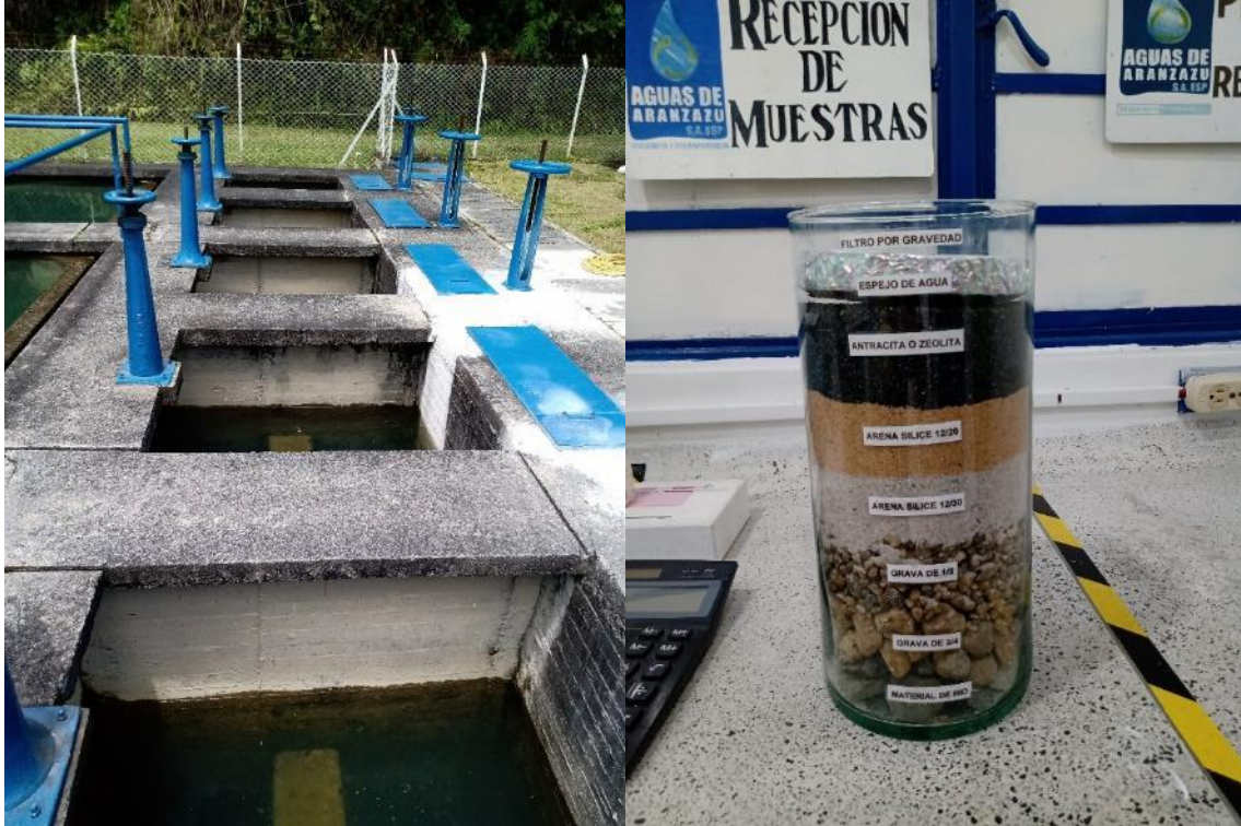
Imagen 18. Filtros (izquierda) y esquema del lecho filtrante (derecha)
