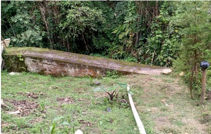
Imagen 24. Conexión de agua residual al box culvert.
