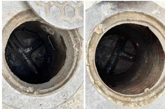
Imagen 1. Pozos de inspección
