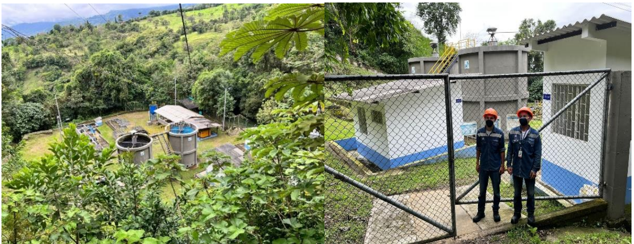
Imagen 3. Vista general y acceso a la Planta de Tratamiento de Aguas Residuales
