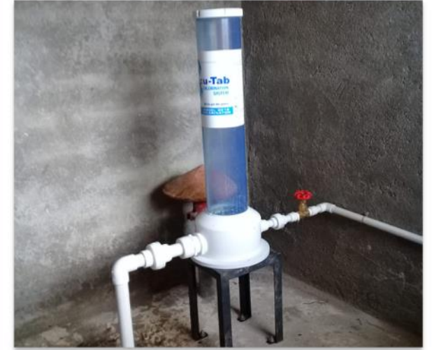
Acueducto Chiles - Cumbal
