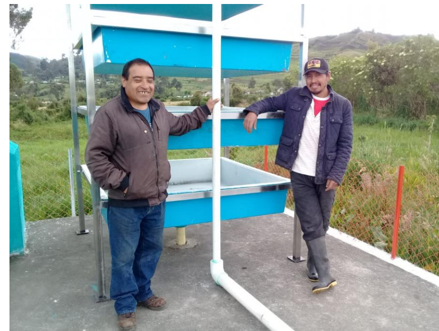
TORRE DE AIREACIÓN
