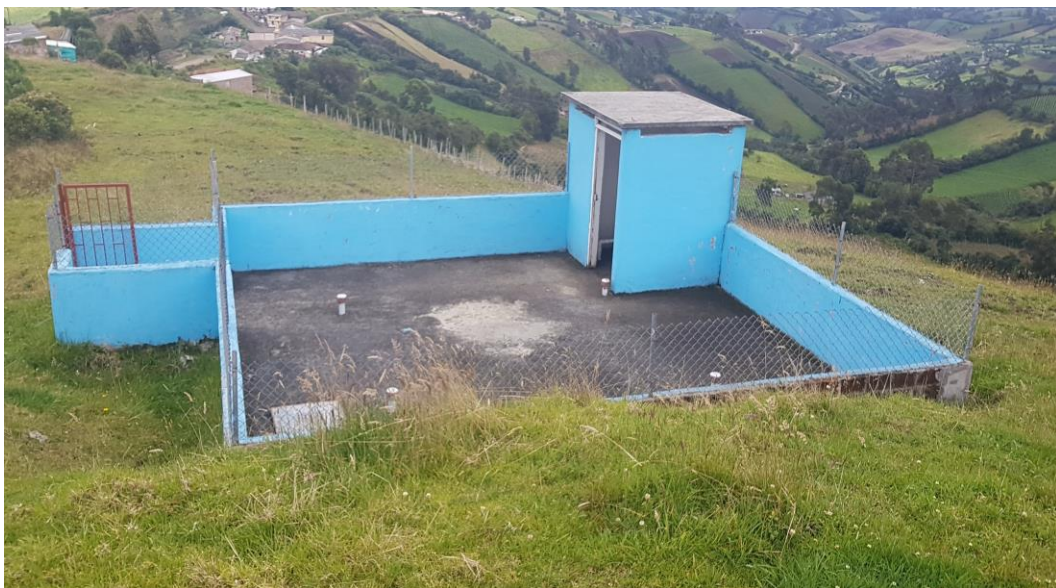
TANQUE ALMACE. Y CASETA
