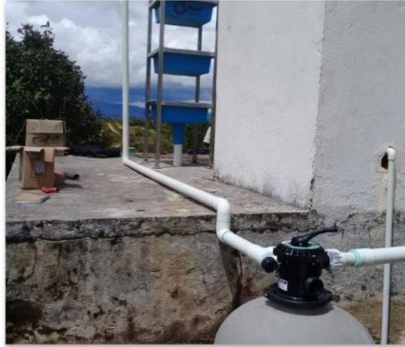
Acueducto Tequez - Ipiales
