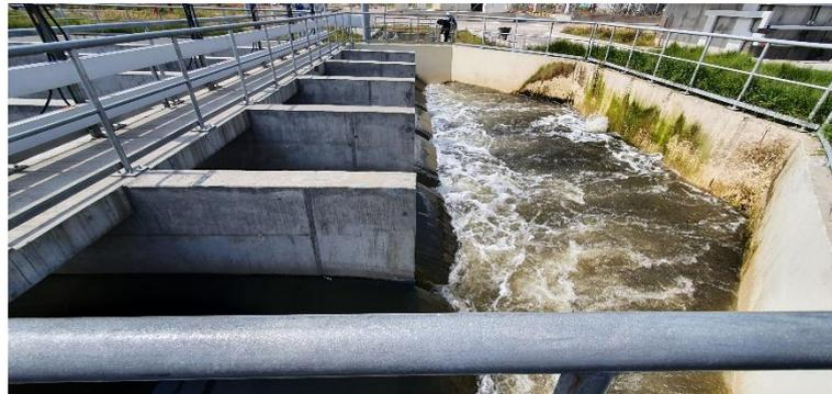
Estructura de salida del agua hacia el vertimiento
