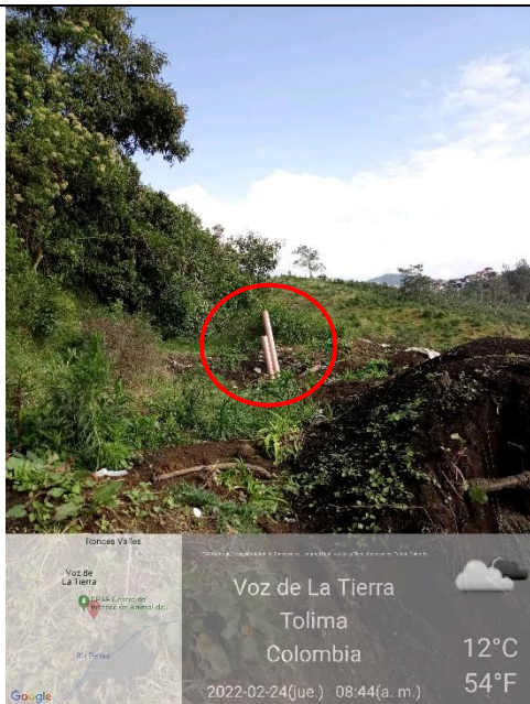
Imagen 24 Verificación 24/02/2022 8:44 a.m. Chimenea de gas.
