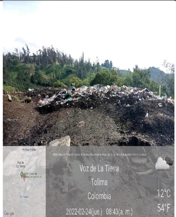
Imagen 23 Verificación 24/02/2022 8:41 a.m. Celda de disposición del Municipio de Roncesvalles – Tolima. Zona activa sin cobertura de tierra.
