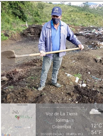
Imagen 26 Verificación 22/02/2022 8:41 a.m. Celda de disposición del Municipio de Roncesvalles – Tolima. Personal sin portar los elementos de protección.
