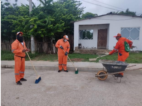
Operarios de barrido con dotación, elementos para realizar la actividad y EPP
