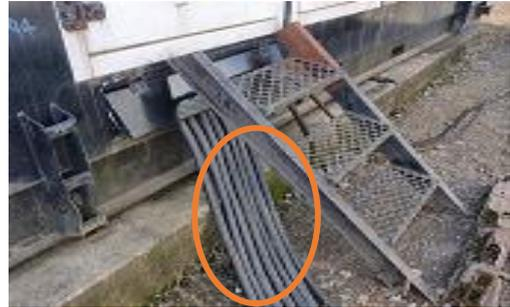
*Unidad alquilada- Unidad de 1000 kW y salida de conductores a celdas subestación*
