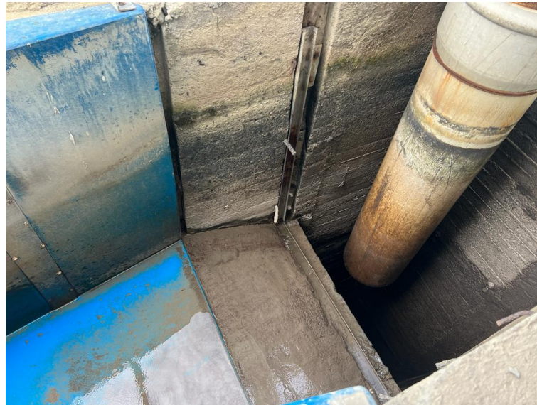
Imagen 10 Estructura de entrada a la PTAP
