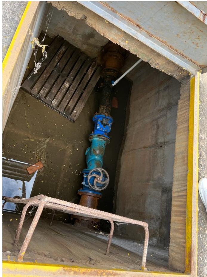
Imagen 20 Macromedidor volumetrico
