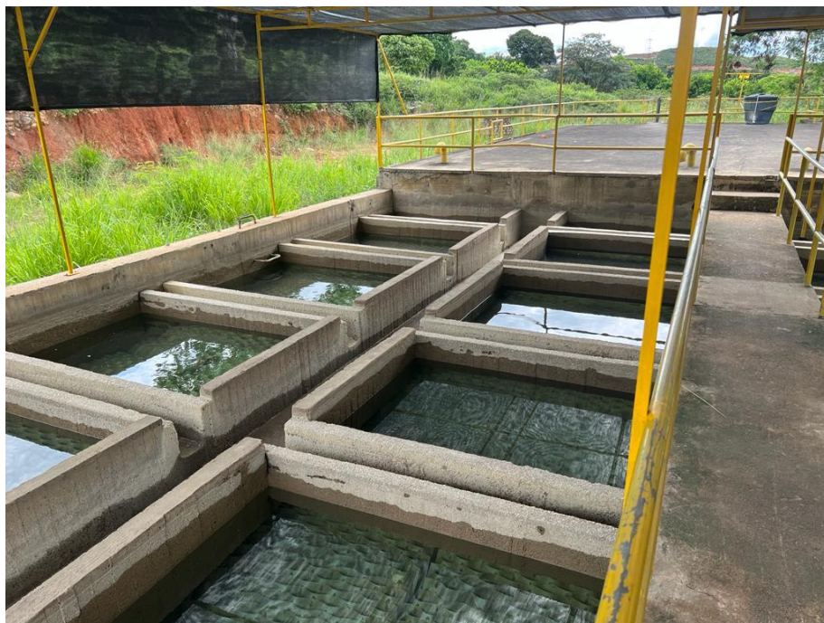
Imagen 15 Sedimentadores
