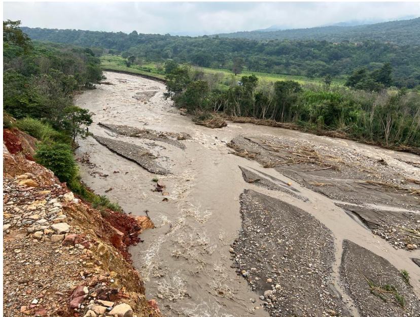
Imagen 1 Río Táchira - Captación
