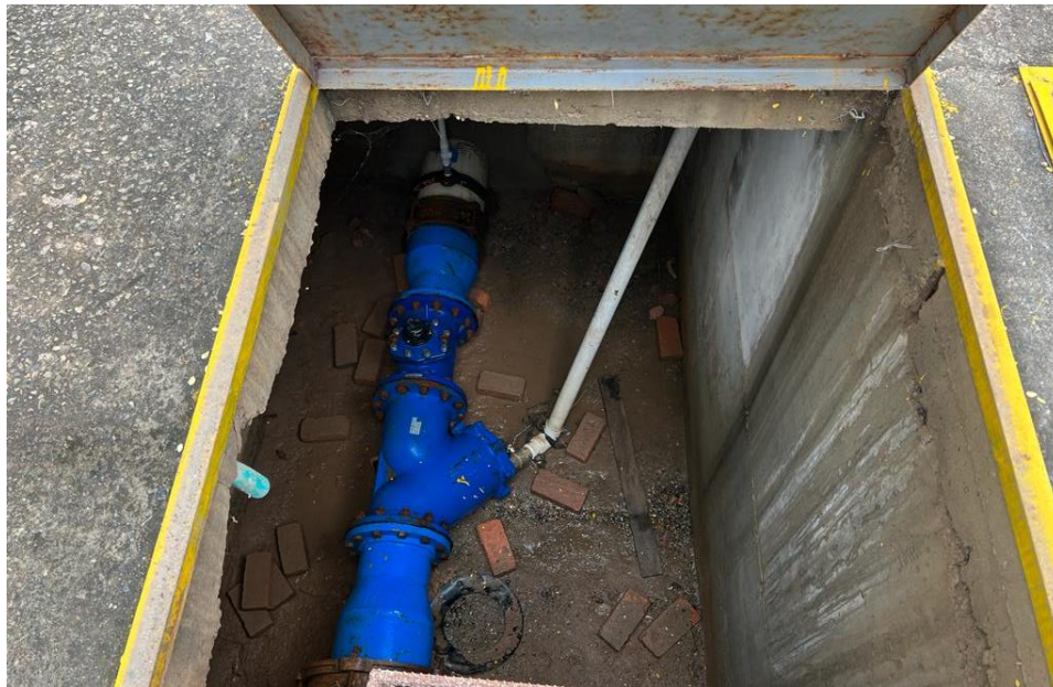
Imagen 21 Macromedidor volumétrico
