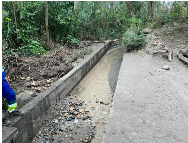
Imagen 2 Canal de conducción - Captación
