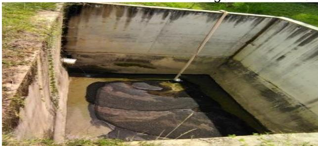
Tanque de homogenización
