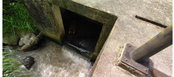
Sistema de compuertas bocatoma
