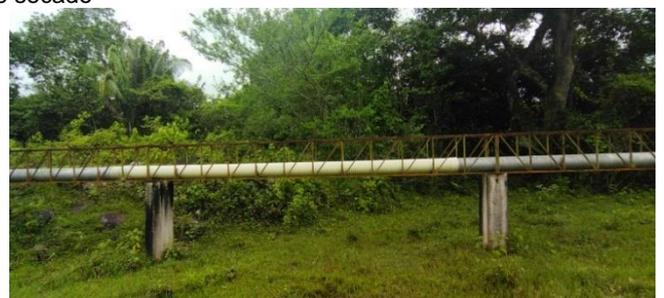
Tubería de paso entre lagunas
