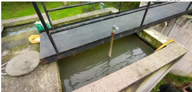
Tratamiento de lodos activados y sedimentación
