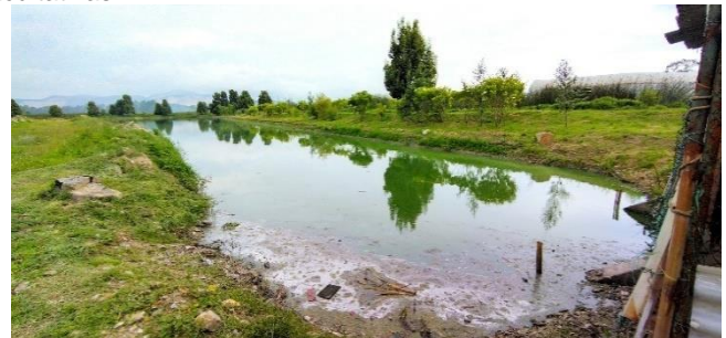
Laguna de maduración
