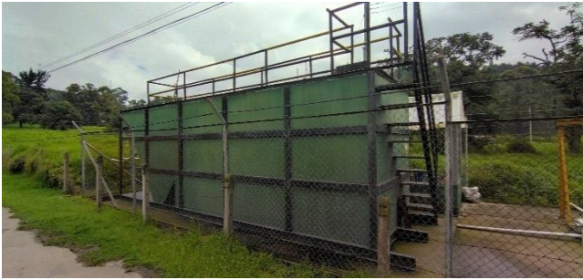
Tratamiento de lodos activados y sistema de bombeo
