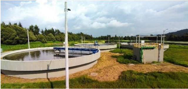
Decantadores secundarios Fuente: Información recopilada en visita
