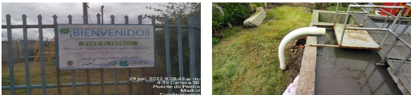
Entrada PTAR El Trébol
