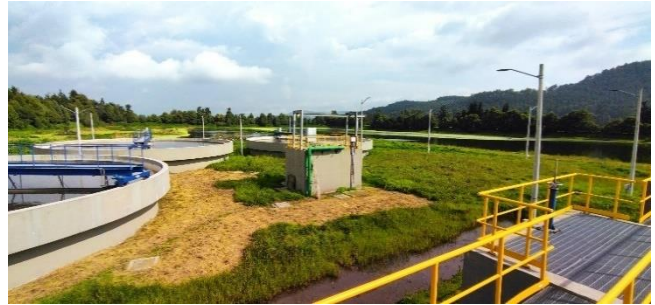
Decantadores secundarios Fuente: Información recopilada en visita
