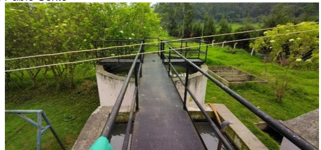
Tratamiento de lodos activados y sedimentación
