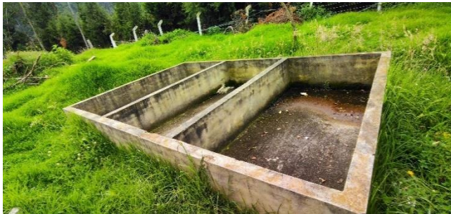
Secado de lodos
