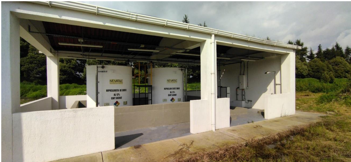
Cloración Fuente: Información recopilada en visita
