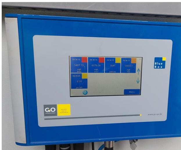
Sensores DBO5, DQO y SST entrada PTAR 2.
