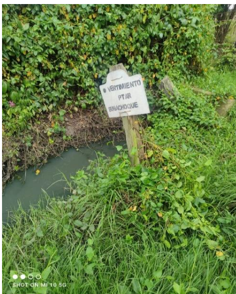
Imagen 6. Descarga de las aguas residuales
