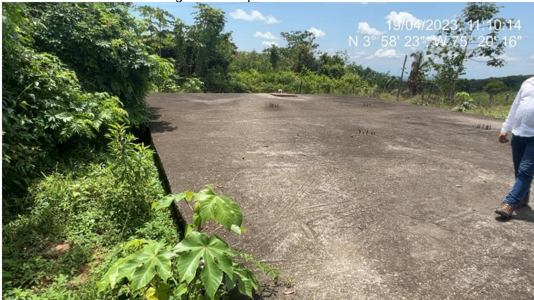
Imagen 28 Tanque de almacenamiento
