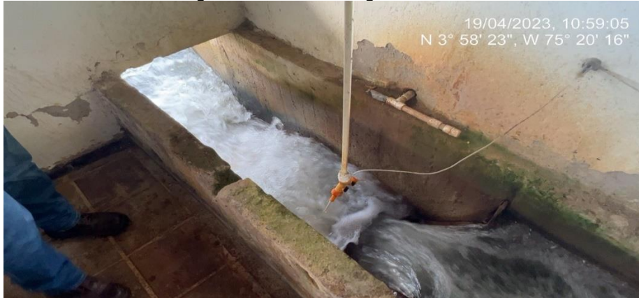
Imagen 20 Entrada de agua a la PTAP
