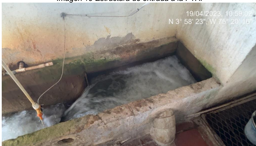
Imagen 19 Estructura de entrada a la PTAP
