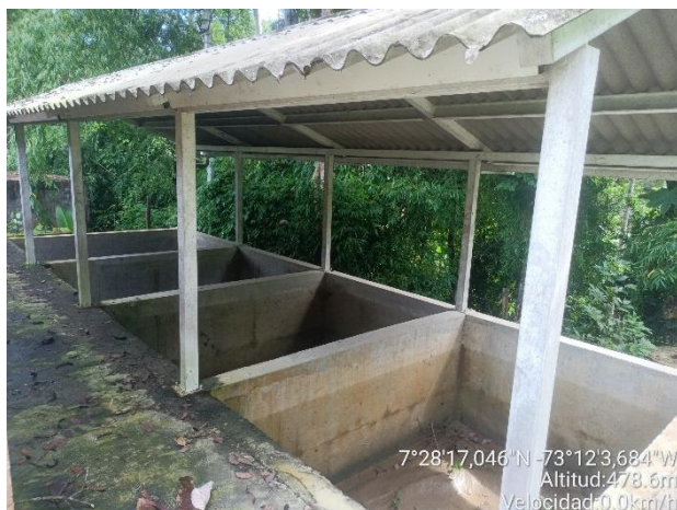
Imagen 15. Vista general de los lechos de secado de lodos.
