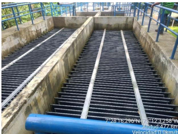
Imagen 13. Vista general sistema de floculación, sedimentadores y filtración no operativos.
