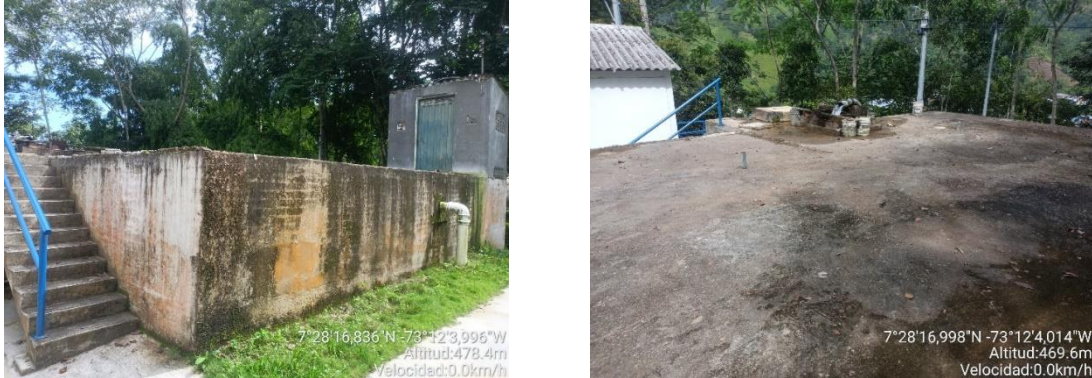
Imagen 18. Vista general del tanque de almacenamiento de agua cruda No. 1.
