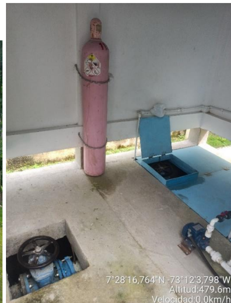
Imagen 17. Vista general del área de cloración no operativa.
