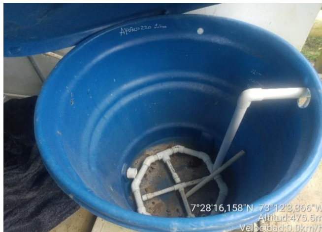
Imagen 14. Vista del área de dosificación de productos químicos no operativa.
