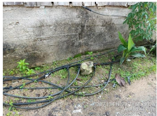
Imagen 10. Vista general zona subnormal “Invasión”, redes de entrega de agua cruda mediante mangueras
