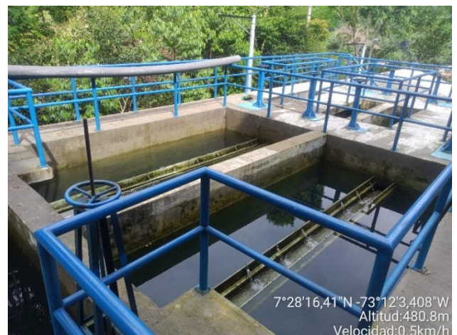
Imagen 13. Vista general sistema de floculación, sedimentadores y filtración no operativos.
