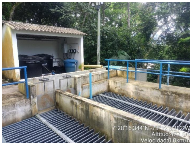
Imagen 14. Vista del área de dosificación de productos químicos no operativa.
