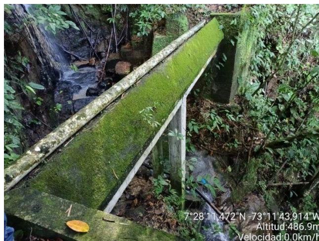
Imagen 12. Paso elevado de las líneas de aducción No. 1 y 2.
