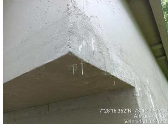
Imagen 16. Vista general de las filtraciones en la PTAP.
