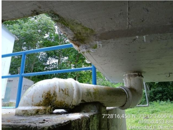
Imagen 16. Vista general de las filtraciones en la PTAP.
