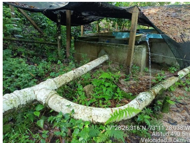
Imagen 8. Desarenador No. 3 (Nuevo)
