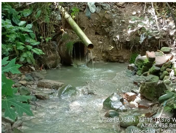
Imagen 34. Punto de vertimiento sector Hamaca.
