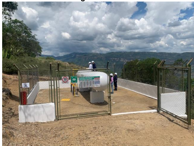
Fuente: SSPD. Foto tomada el 26/07/2023 en la visita a campo
