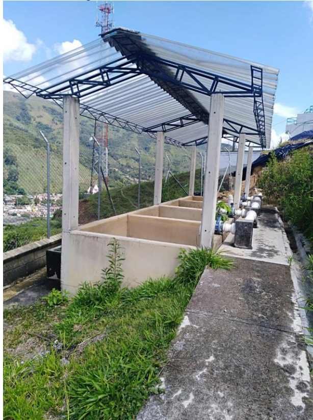
Imagen 9 Unidades de Filtración
