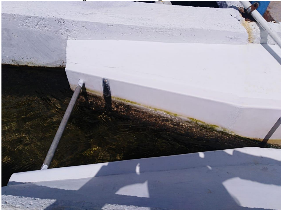
Imagen 6 Estructura de ingreso a la PTAP
