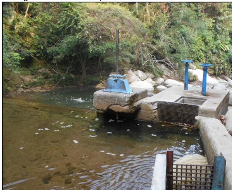
Imagen 2 Sistema de captación Quebrada Santa Gertrudis
