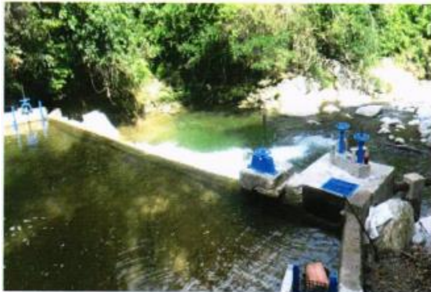
Imagen 1 Quebrada Santa Gertrudis – Captación
