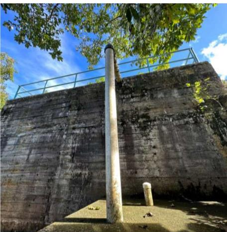
Vista lateral y tubería de salida del tanque en PVC 8 pulgadas
