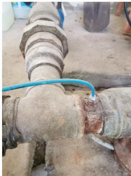
Dosificación en pozo
