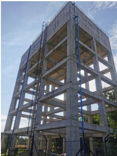
Tanque elevado y sistema de tratamiento en la parte elevada del tanque
