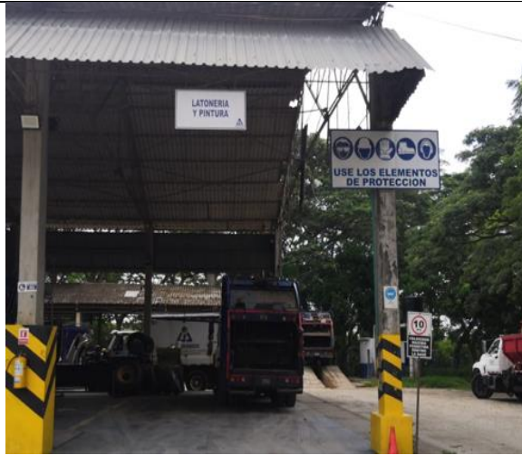
Imagen 59. Taller de mantenimiento.
