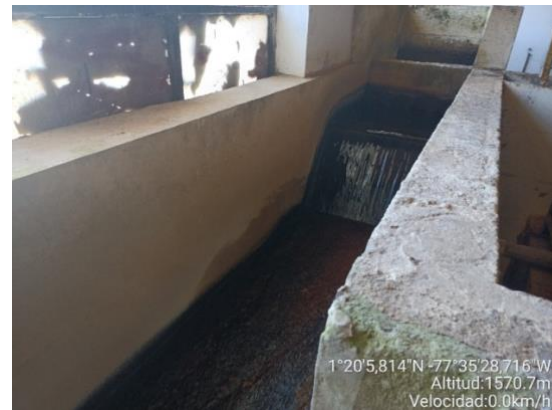
Imagen 8. Vista general de la PTAP El Monumento, canal de ingreso del agua proveniente de la PTAP Puerchag y sistema de cloración de la PTAP El Monumento.
