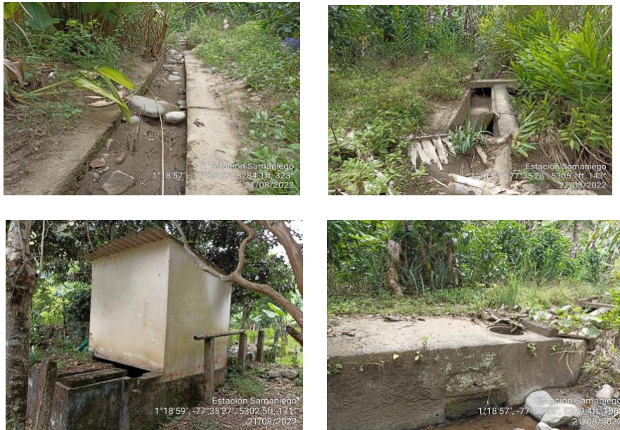
Imagen 5. Estructuras de captación bocatoma antigua (no operativa)
