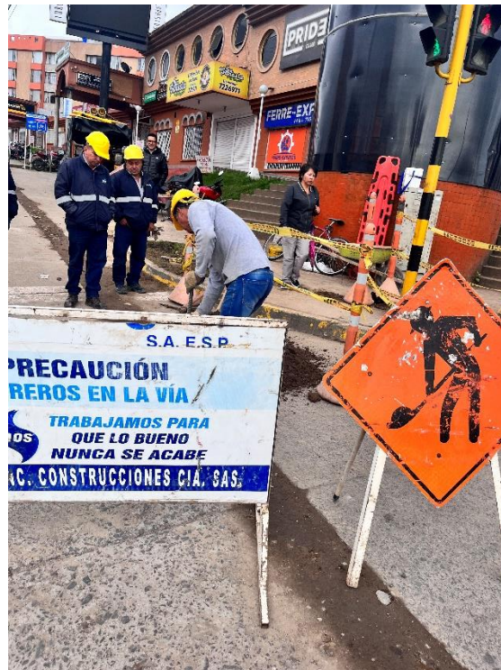
Imagen 5 Zona donde se realizó el apique en el cual la distancia de seguridad entre la cinta y el tubo fue entre 4cm y 6cm
