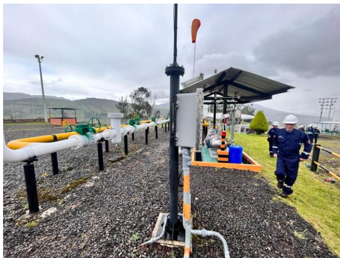
Imagen 4 Estación de regulación que regula la presión a 55psi
