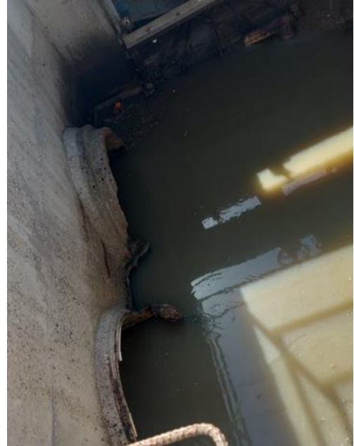
Cámara de entrada
