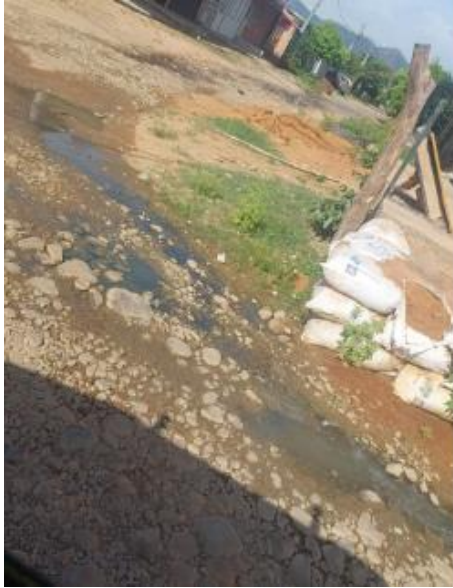
Agua residual circulando
