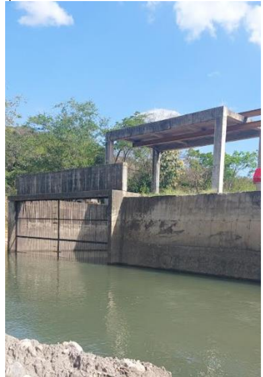
Estructura de captación
