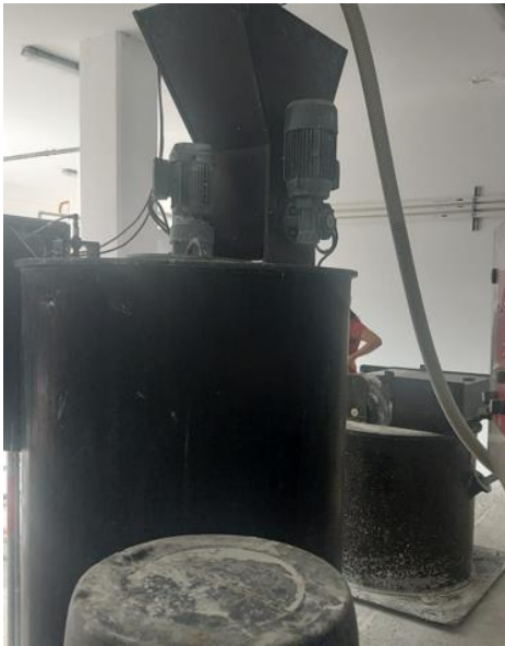
Preparación lechada de cal
