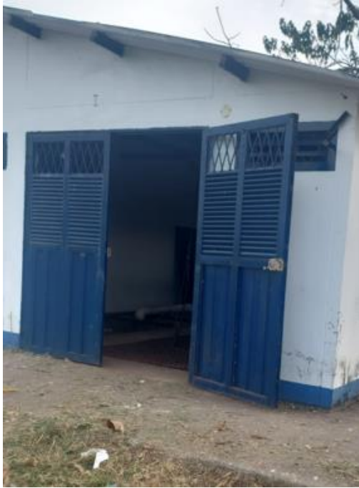
Entrada estación de bombeo
