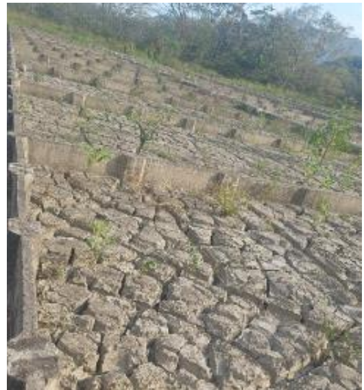
Módulo de secado sedimentadores
