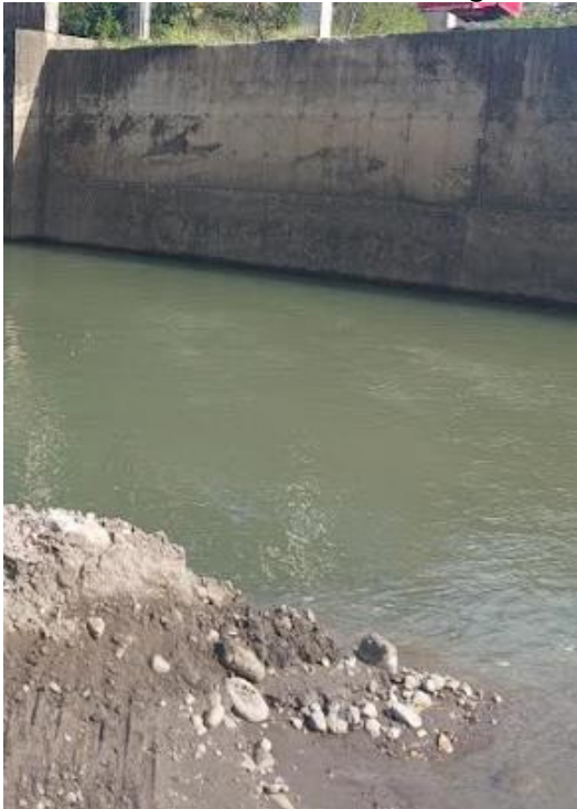
Canal de derivación
