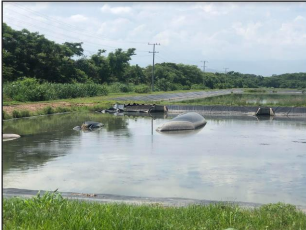
Imagen 49. Laguna facultativa con desprendimiento de membrana
