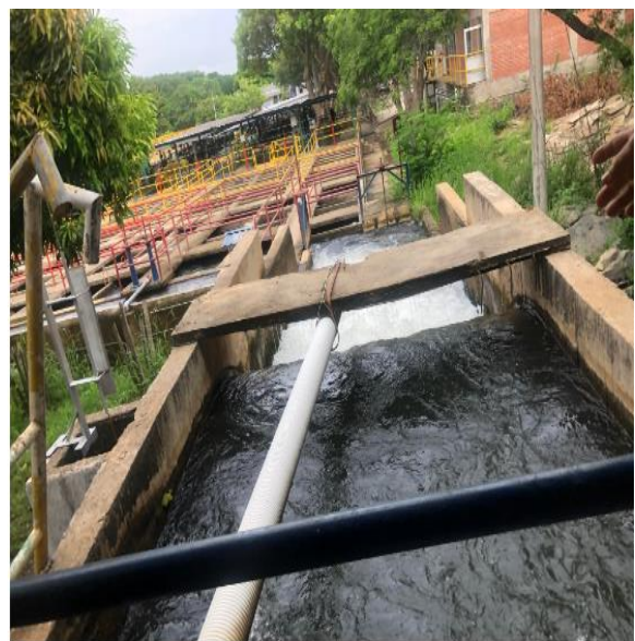
Imagen 21. Mezcla rápida por resalto hidráulico Gota Fría
