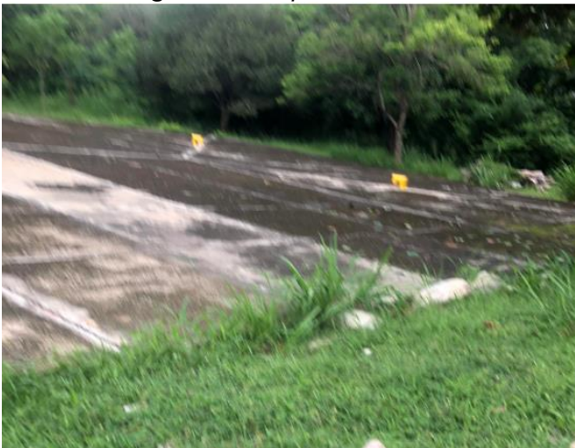
Imagen 26. Tanque contacto de cloro
