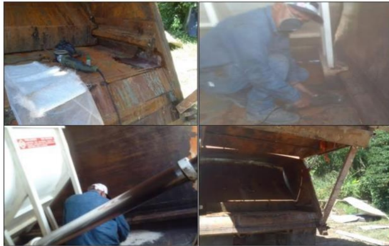
Fuente: INFORME DE MEDIDAS CORRECTIVAS AL VEHICULO COMPACTADOR – 13 de septiembre del 2023”
