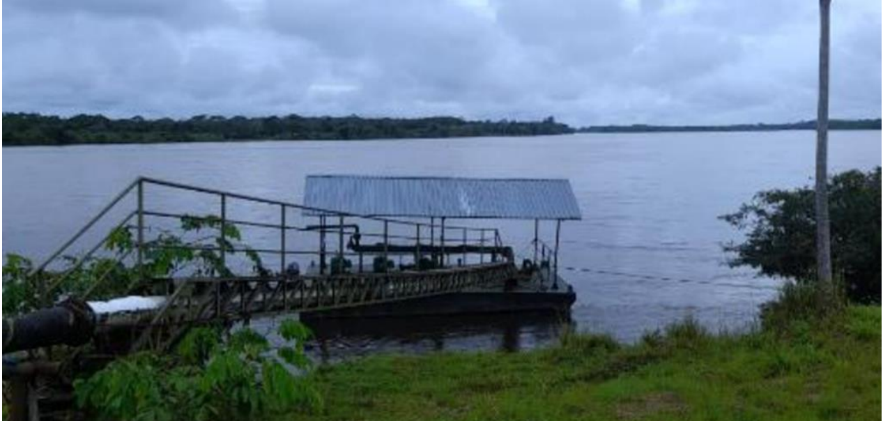
Imagen 4. Bocatoma sistema de acueducto de Puerto Leguízamo.
