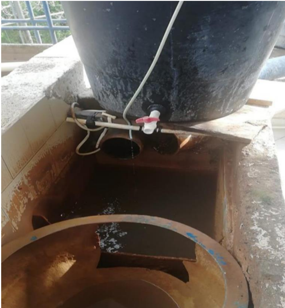
Imagen 11. Adición de coagulante sistema de acueducto de Puerto Leguízamo.
