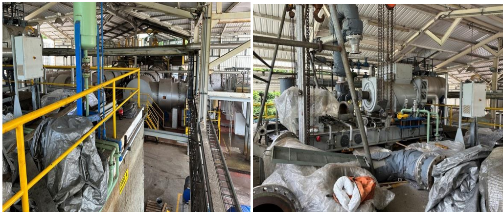
Planta de Generación Residuos Sólidos Urbanos – RSU – SOPESA
