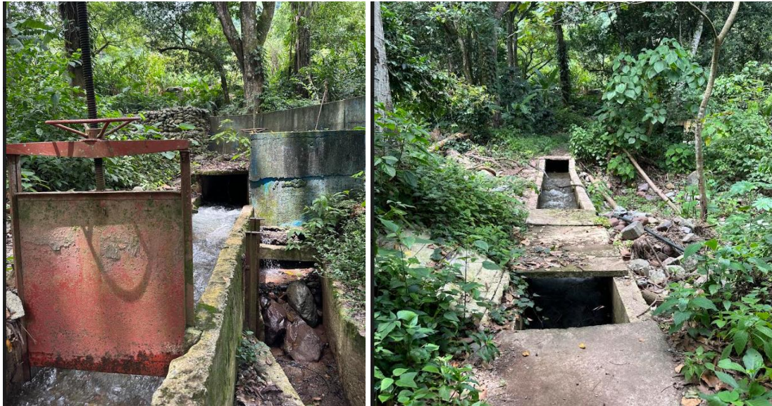
Imagen 5. Línea aducción de captación a desarenador
