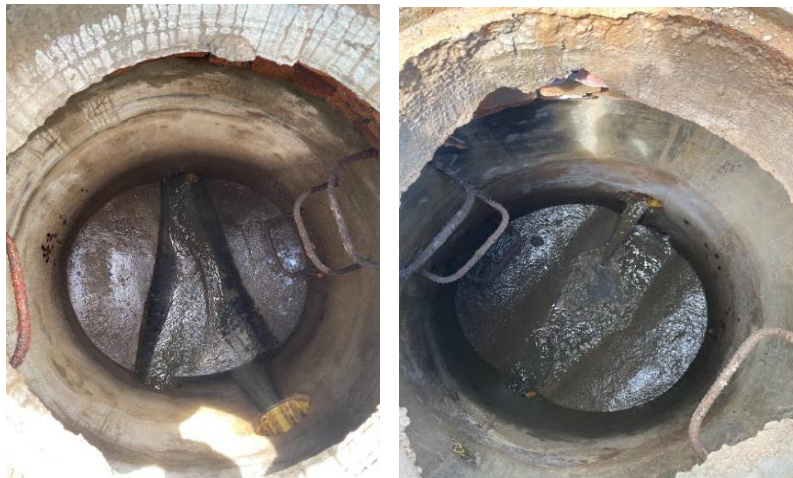
Imagen 8. Pozos de inspección sanitaria visitados
