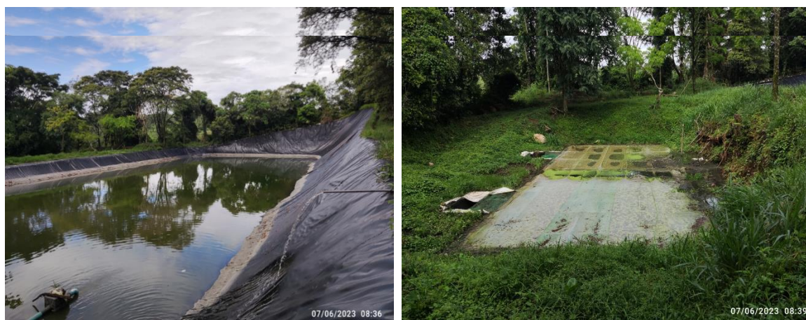
Imagen 11. PTAR y punto de vertimiento
