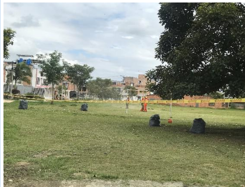
Delimitación del área, operarios con guadaña y empaque de residuos.
