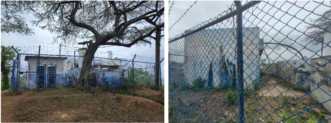
Imagen 16. PTAP, corregimiento de Guaquiri
