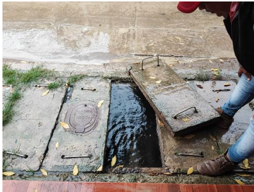
Imagen 20. Inspección de macromedidor en red de distribución
