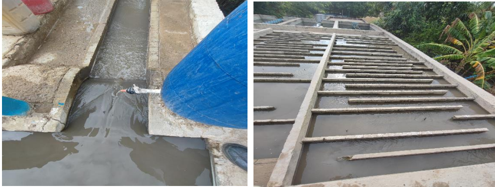
Imagen 14. Floculadores, corregimiento de Heredia
