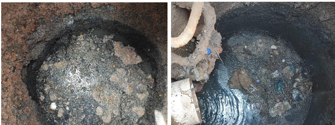
Imagen 24. Pozos de inspección de alcantarillado
