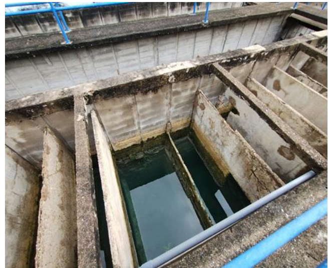
Láminas de concreto
