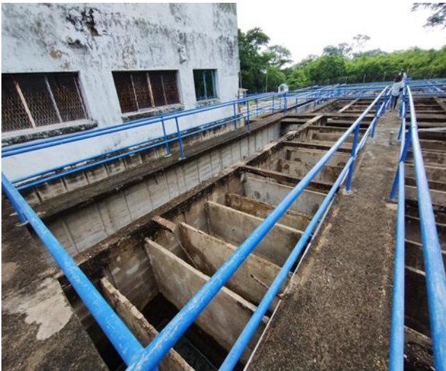
Módulos de floculación
