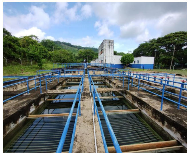
Sistema de sedimentación
