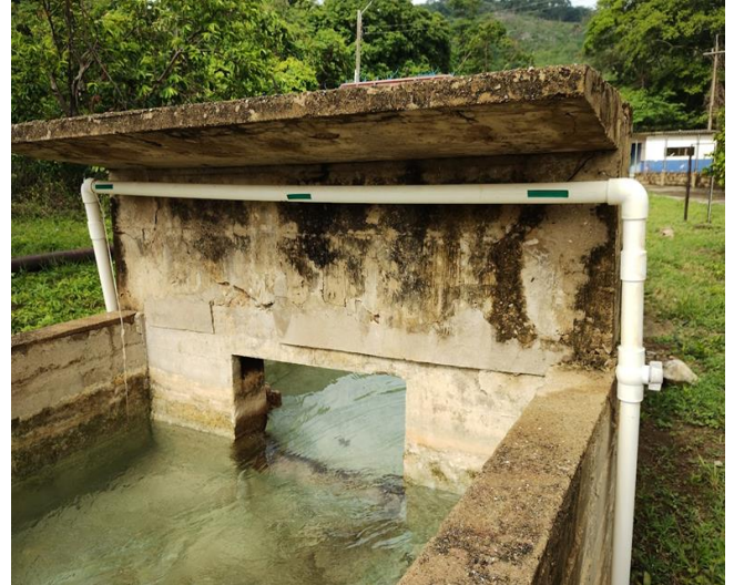
Canaleta entre desarenadores y módulos de floculación
