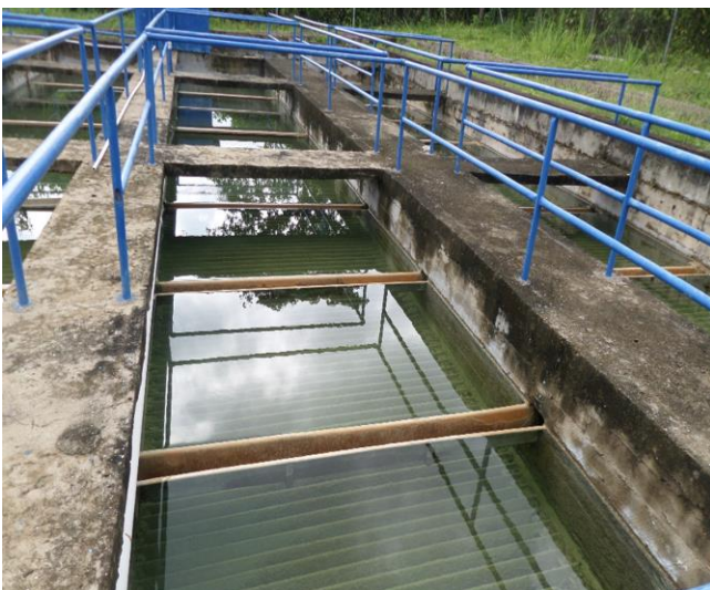
Sistema de sedimentación
