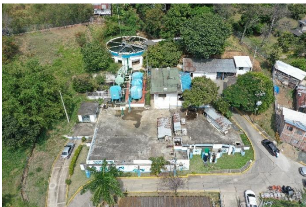
Vista general de la planta
