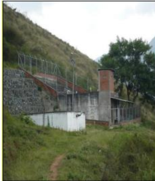
Imagen 18. Tanques de almacenamiento
