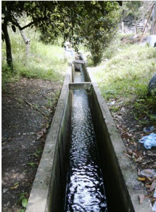
Imagen 15. Canal de Aducción
