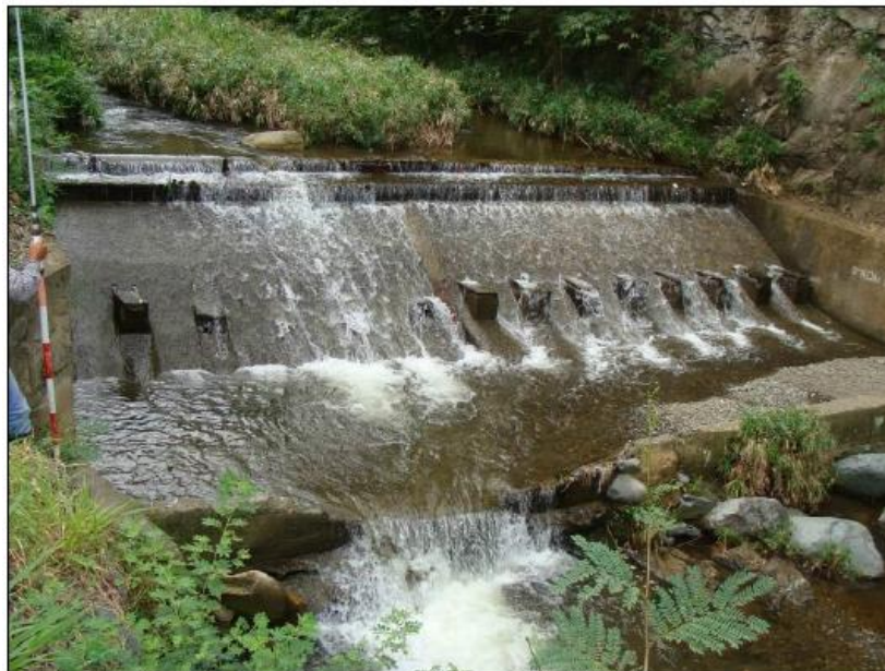
Imagen 14. Estructura de captación
