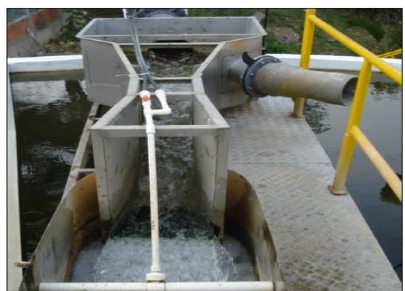
Canal de entrada
