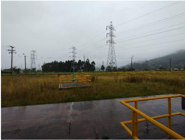
Ingreso a la PTAR
