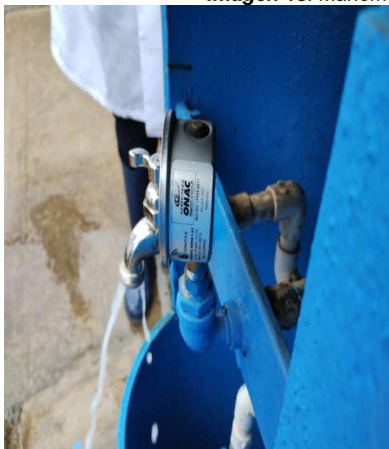
Imagen 18. Manómetros en puntos concertados.
