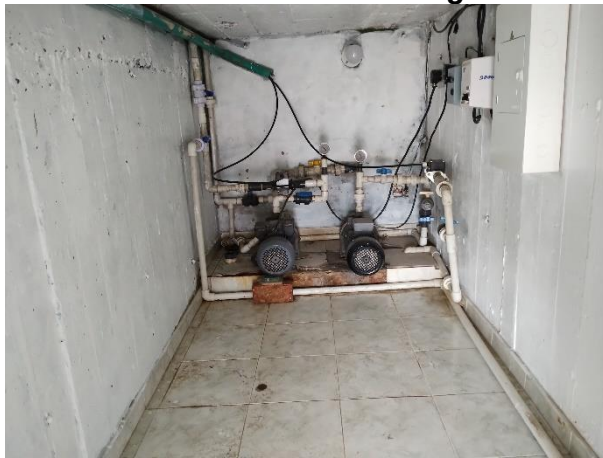
Sistema de dosificación de cloro
