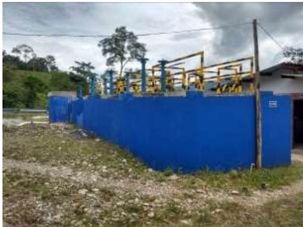
Imagen 34 Cuatro módulos de filtración descendente de arenas
