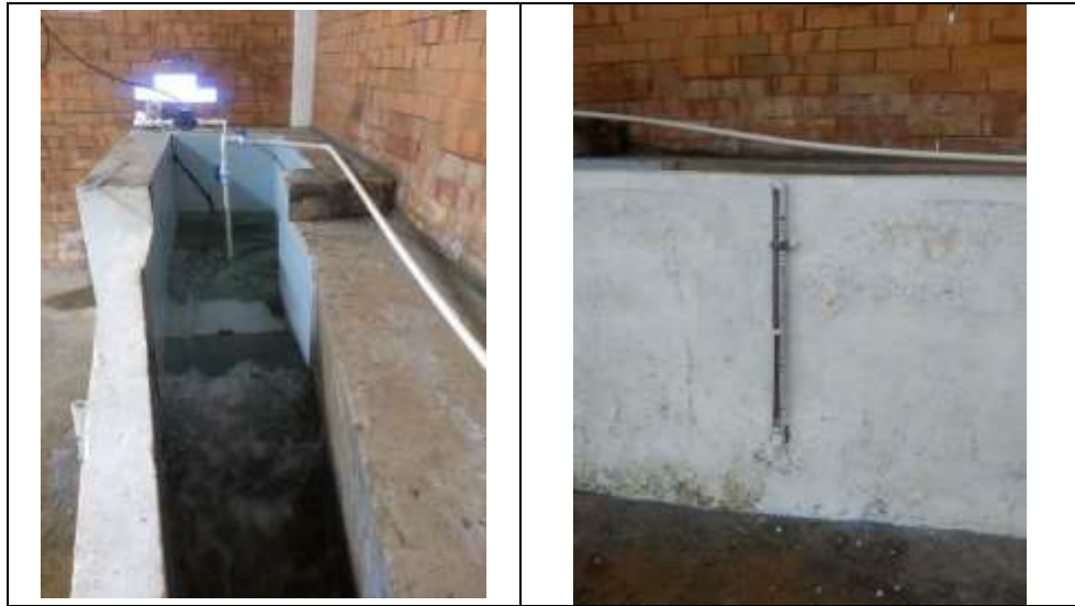
Imagen 34 Cuatro módulos de filtración descendente de arenas
