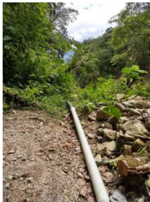
Imagen 27 Línea de aducción Quebrada Taruquita en 4"
