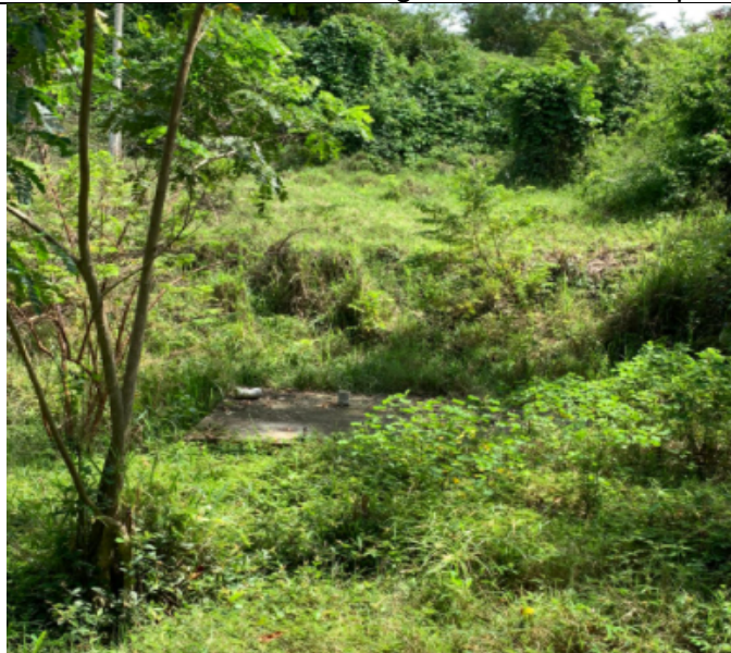
Tanque de lixiviados
