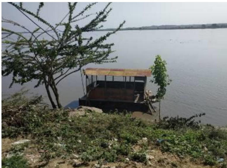
Imagen 13. Captación sobre barcaza flotante
