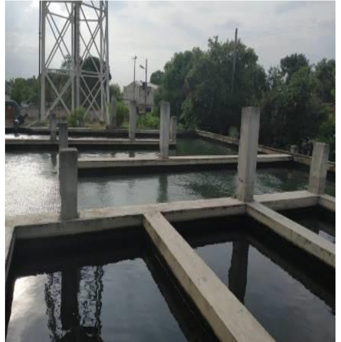
Tanque Bajo Antigua Planta de Tratamiento 900 m3
