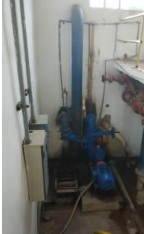
Imagen 11. EBAP Planta de Tratamiento
