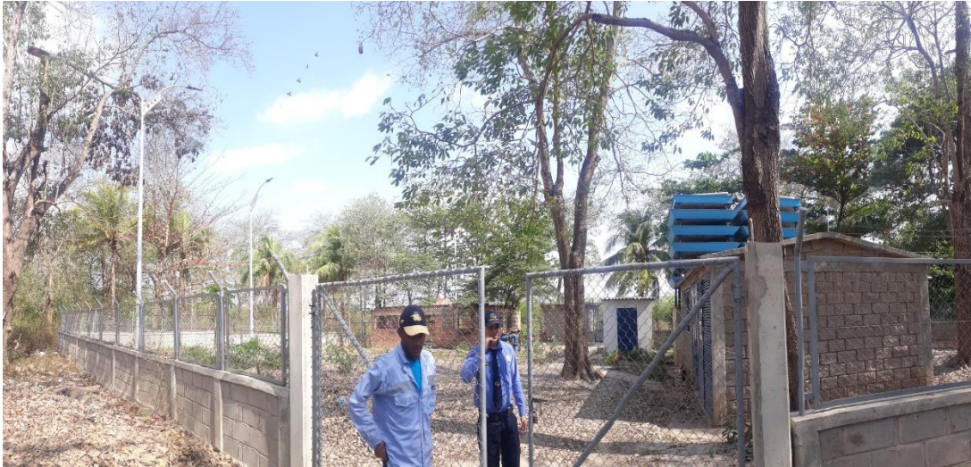
Cerramiento perimetral pozo Villa Lady Fuente: Visita de inspección SSPD
