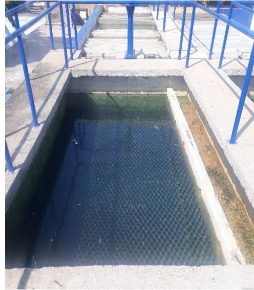
Sedimentadores tipo colmena
