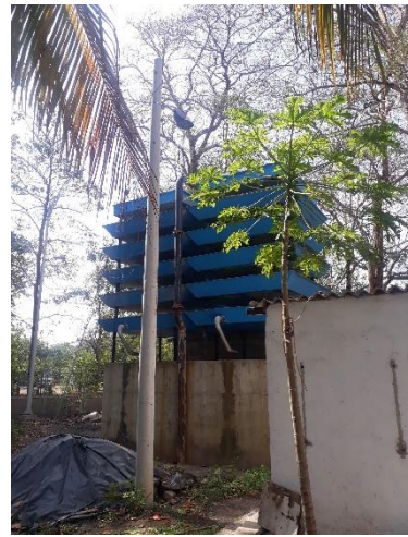
Bandejas de aireación
