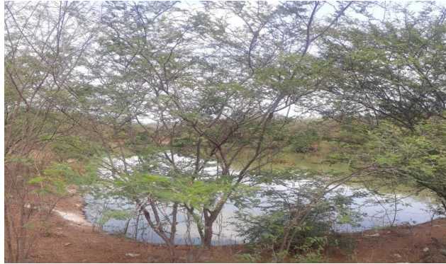
Laguna de oxidación
