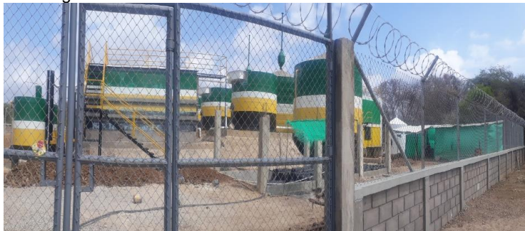
Cerramiento y vista lateral PTAR
