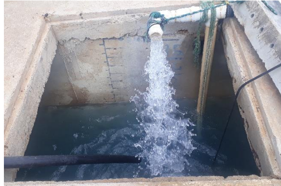
Punto de aireación y dosificación cloro
