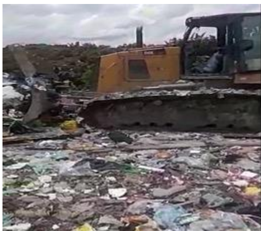
Imagen 43. Compactación residuos sólidos celda en operación
