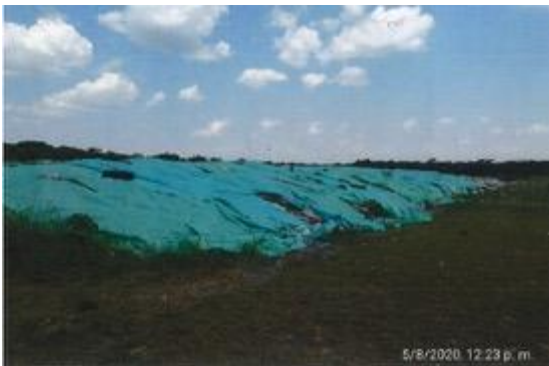
Imagen 29. Cubrimiento diario de los residuos
