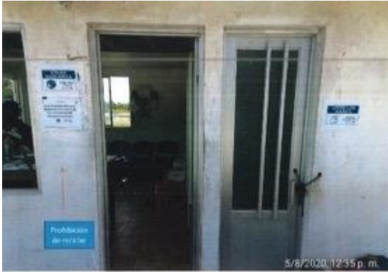
Imagen 33. Caseta de operaciones
