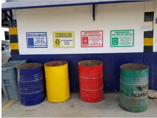
Ilustración 35. Canastos para residuos sólidos no domiciliarios. Fuente: Visita de inspección y vigilancia del 19 y 20 de septiembre de 2017
