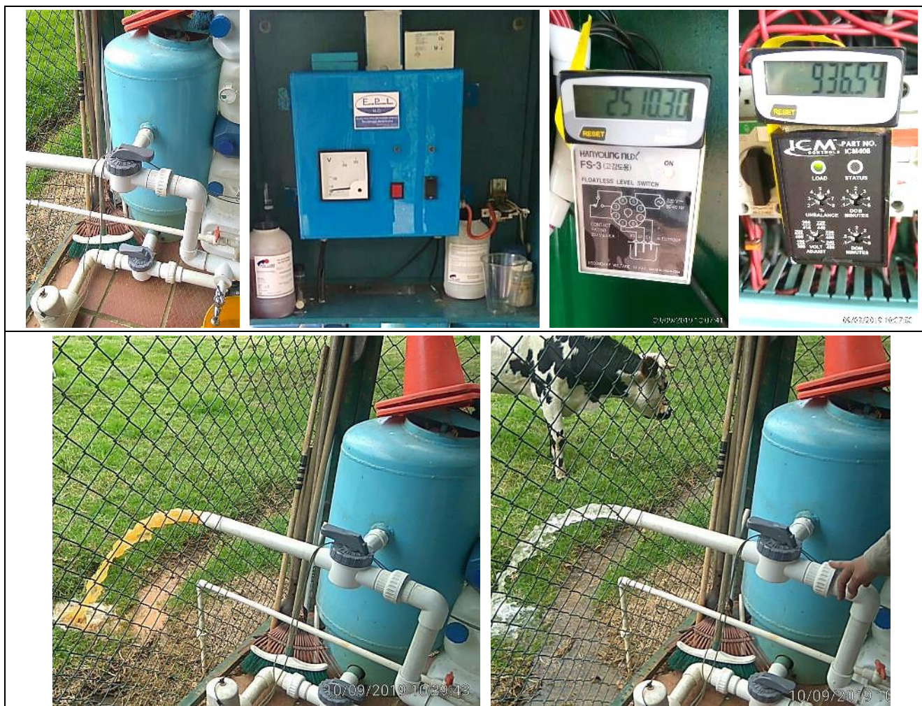
Fuente: Visita de inspección
