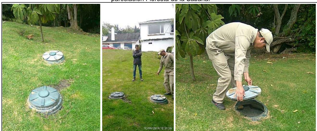
Imagen 17. Verificación estado de funcionamiento de tanque séptico en una vivienda de la parcelación Floresta de la Sabana.
