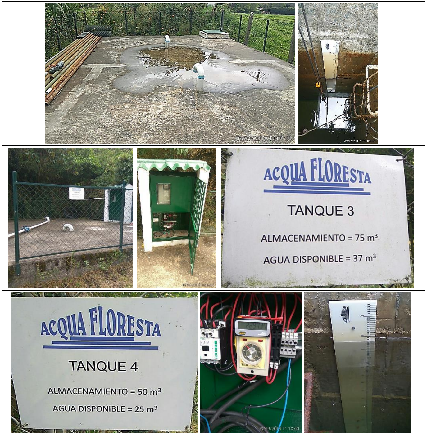
Fuente: Visita de inspección
