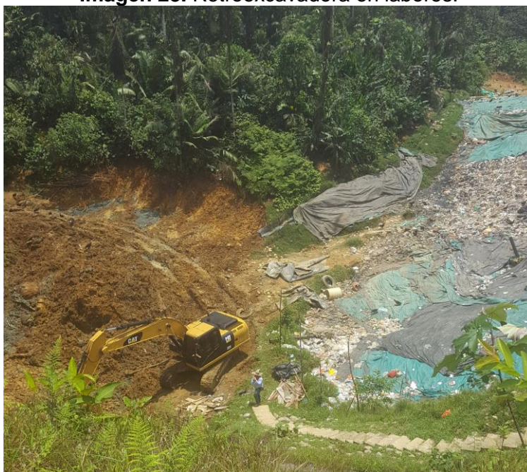
Imagen 28. Retroexcavadora en labores.
