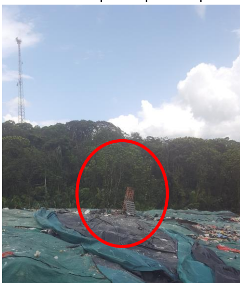
Imagen 26. Chimenea que ha perdido posición vertical
