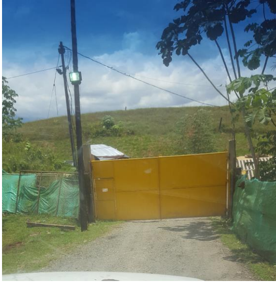
Imagen 7. Ingreso a la Celda Transitoria.
