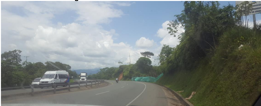
Imagen 6. Vía nacional de acceso al relleno.
