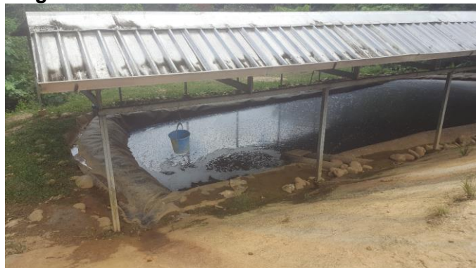
Imagen 21. Piscina de almacenamiento de lixiviados.
