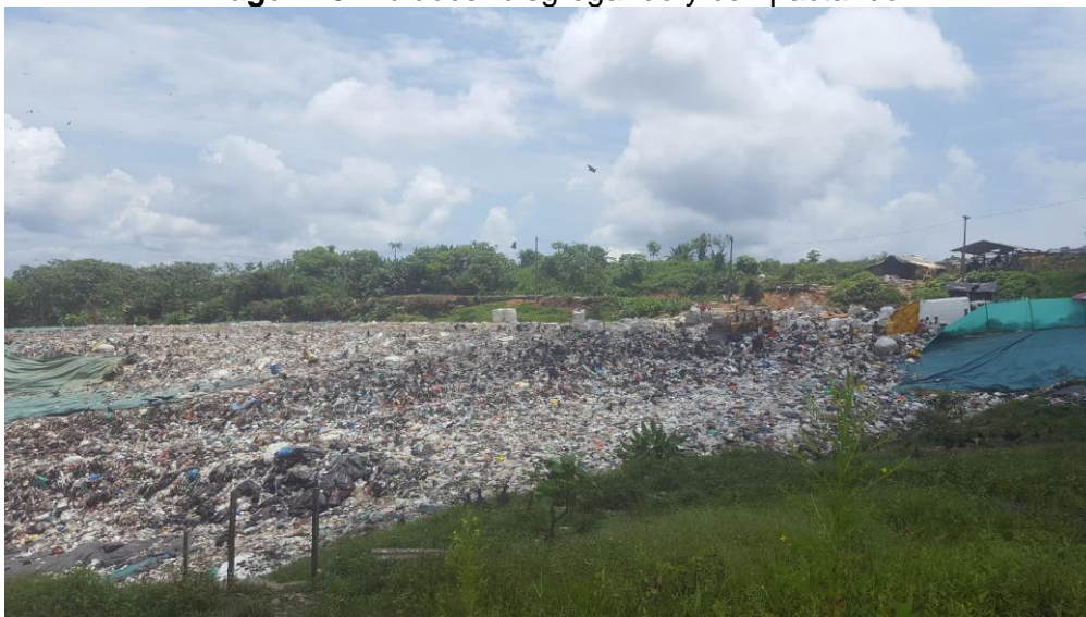
Imagen 15. Buldócer disgregando y compactando.
