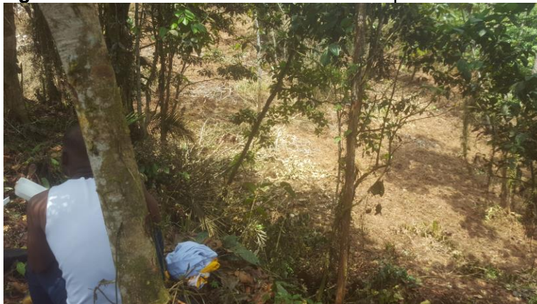
Imagen 31. Zona de inicio de adecuaciones optimización vaso 1.
