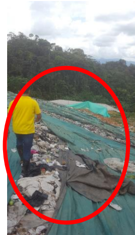
Imagen 17. Traslape de lonas con residuos expuestos.
