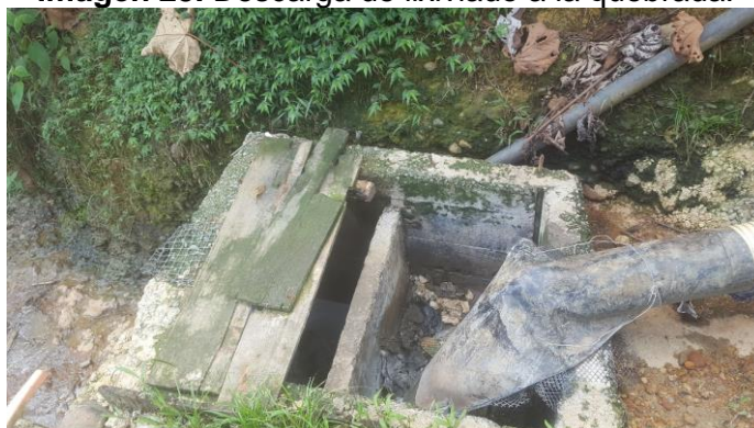
Imagen 23. Descarga de lixiviado a la quebrada.
