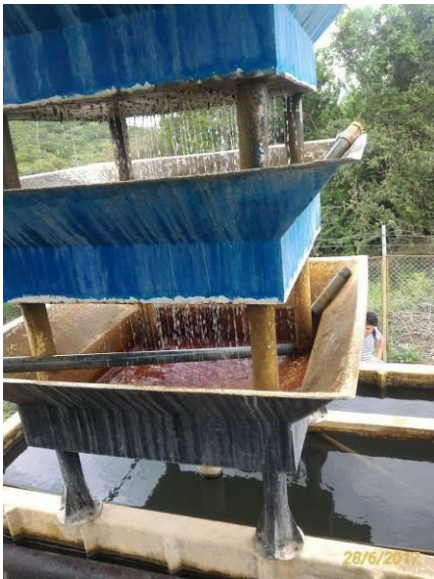
Foto 24 Aireación- Floculación
