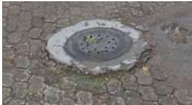
Foto 29 Pozo de inspección 7
