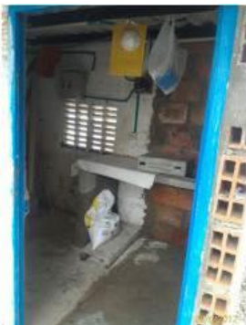
Foto 26 Cuarto de almacenamiento
