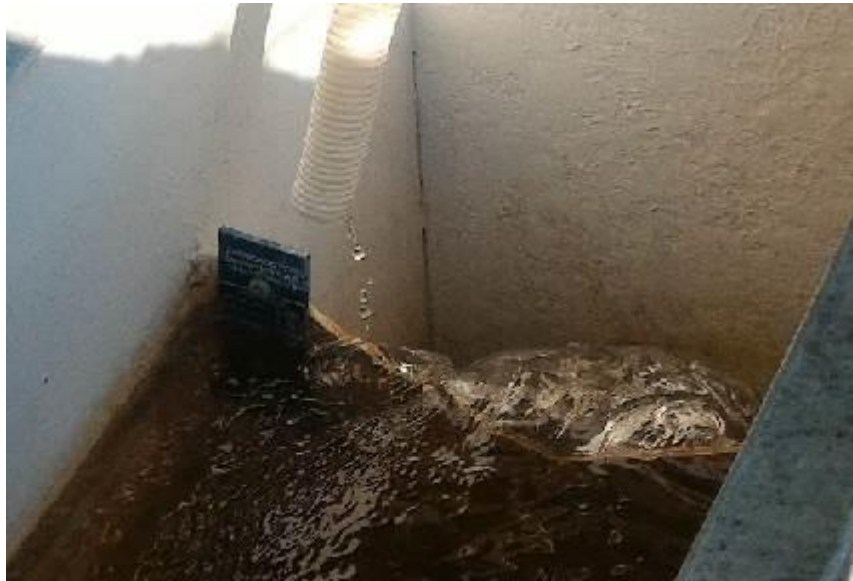
Foto 16 Medición de caudal al ingreso de la PTAP
