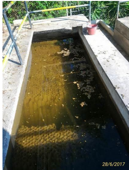
Foto 7 Sedimentador colmatado
