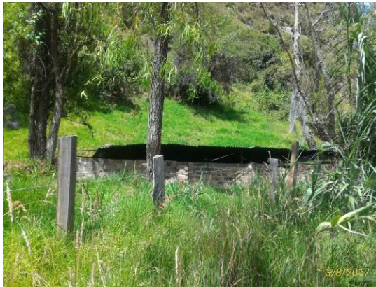
Foto 1 Cerramiento Captación Nacimiento “Los Borracheros”
