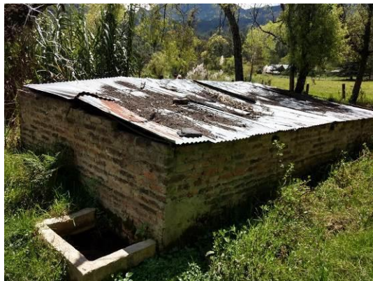
Foto 3 Caseta de Captación
