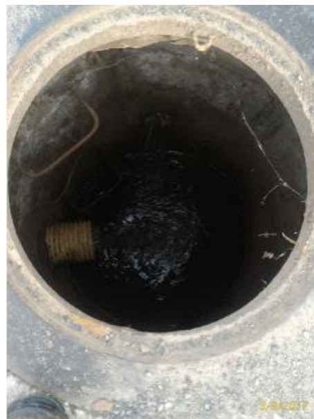
Foto 14 Pozo de inspección
