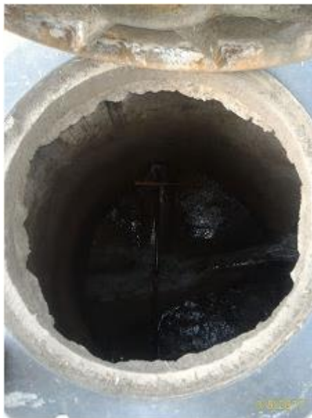
Foto 13 Pozo de inspección
