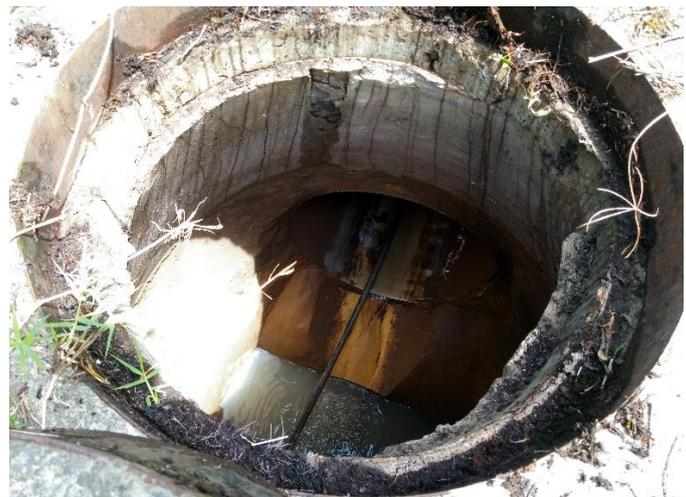
*Imagen 51 Punto de vertimiento del sistema de alcantarillado previa descarga a quebrada Santa Isabel (Estructura de alivio)*
