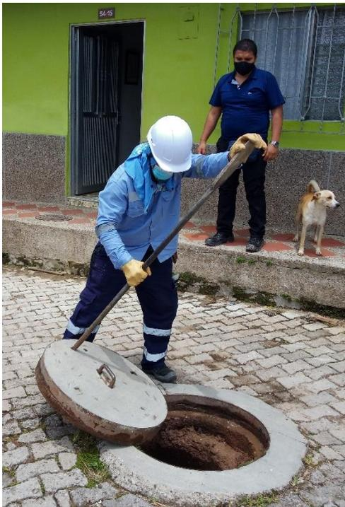
*Imagen 38 Inspección del pozo de inspección sobre la vía que conduce al Relleno Sanitario.*
