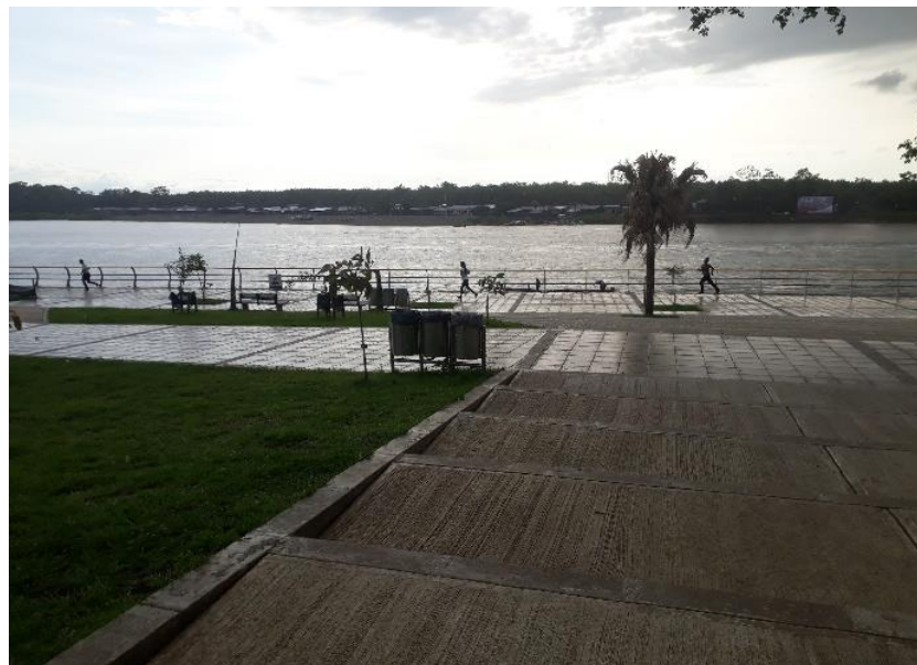
Imagen 45. Cestas instaladas en el Malecon Río Atrato-Quibdó.
