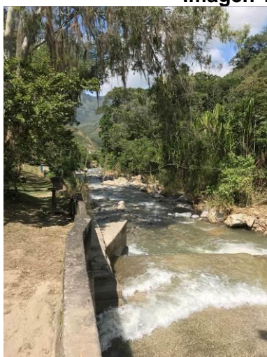
Estructura de captación
