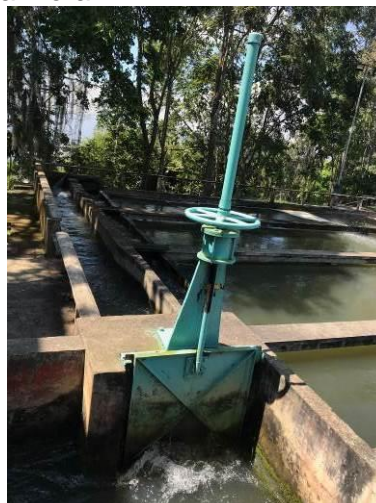
Canal de repartición hacia los floculadores
