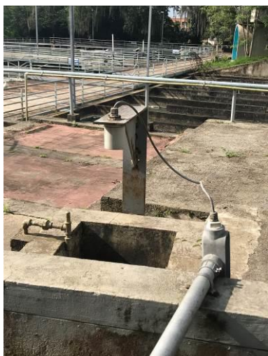
Medición del caudal de entrada en la canaleta parshall
