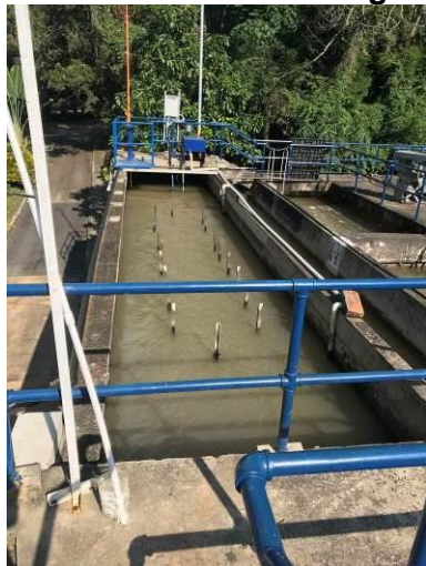
Aireación con difusores
