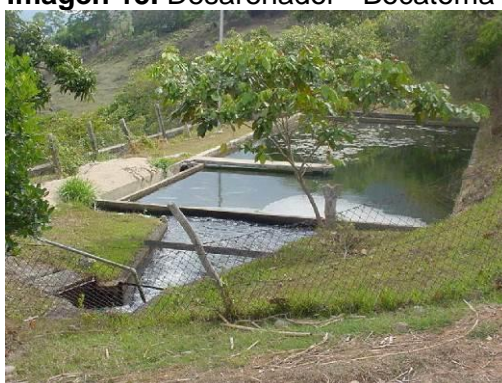
Imagen 15. Desarenador - Bocatoma Arnania
