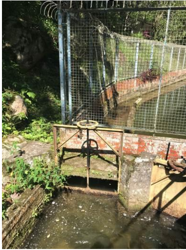
Entrada al desarenador
