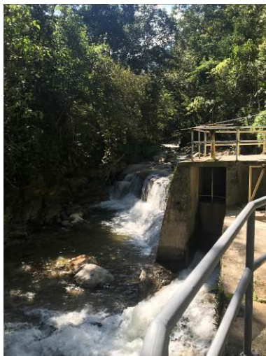
Estructura de captación
