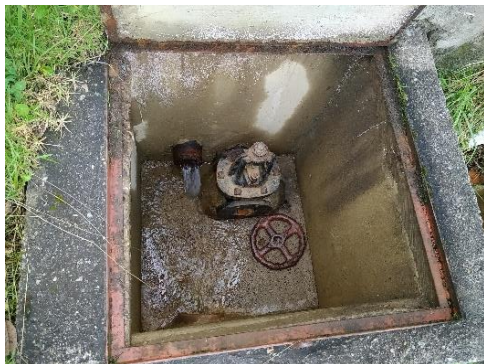
Fotografía N° 15 Válvula de retrolavado
