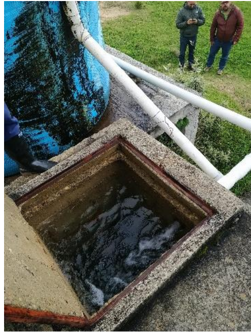
Fotografía N° 11 Dosificador de Cloro
