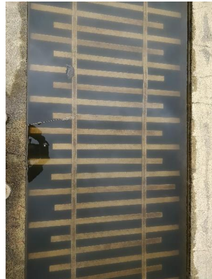
Fotografía N°52 Floculador flujo horizontal
