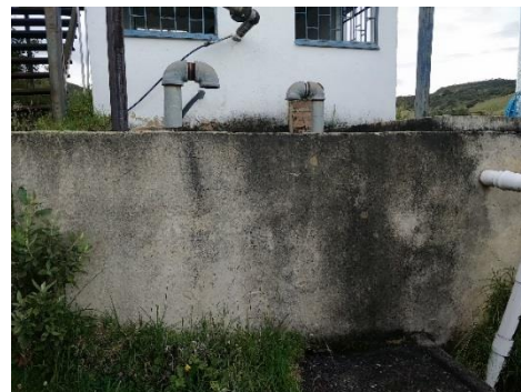
Fotografía N° 16 Tanque de succión/distribución
