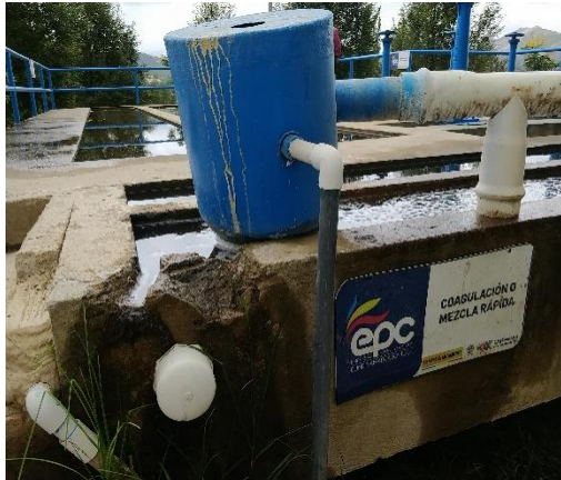
Fotografía N°49 Coagulación y Mezcla rápida
