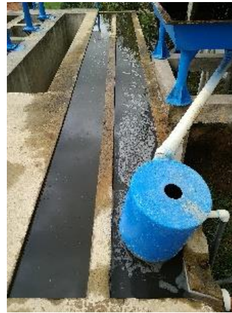
Fotografía N°52 Floculador flujo horizontal
